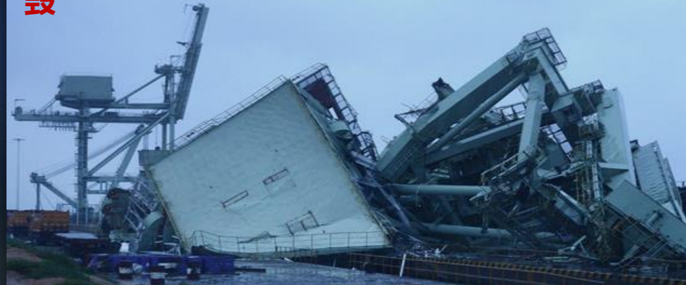
东海岛湛江钢铁基地原料码头的龙门吊被摧毁
